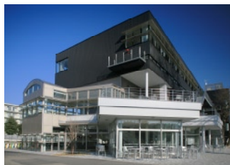
③ 川内サブアリーナ棟
