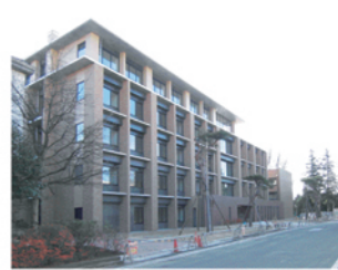
④ 生命科学プロジェクト総合研究棟
